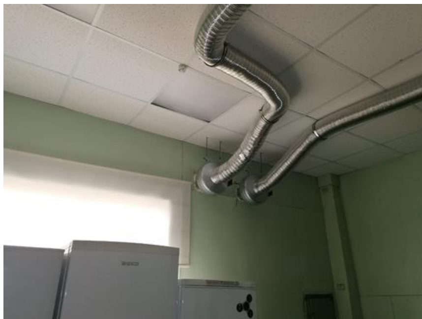
Рис. 4. Вывод системы вентиляции пищеблок МКОУ СОШ с. Преображенка
