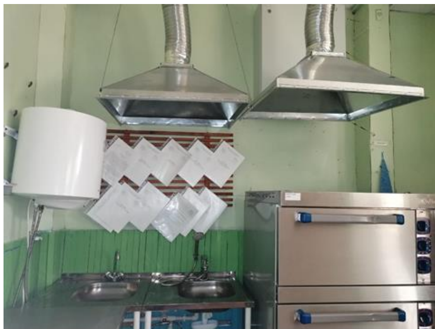
Рис. 2. Вентиляционная система над моечными раковинами и жарочным шкафом на пищеблоке МКОУ СОШ с. Преображенка
