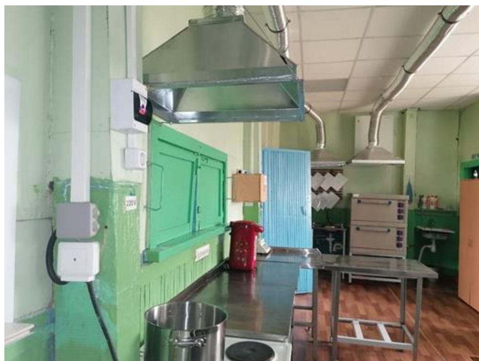
Рис. 3. Вентиляционная система над плитой (пищеблок МКОУ СОШ с. Преображенка)
