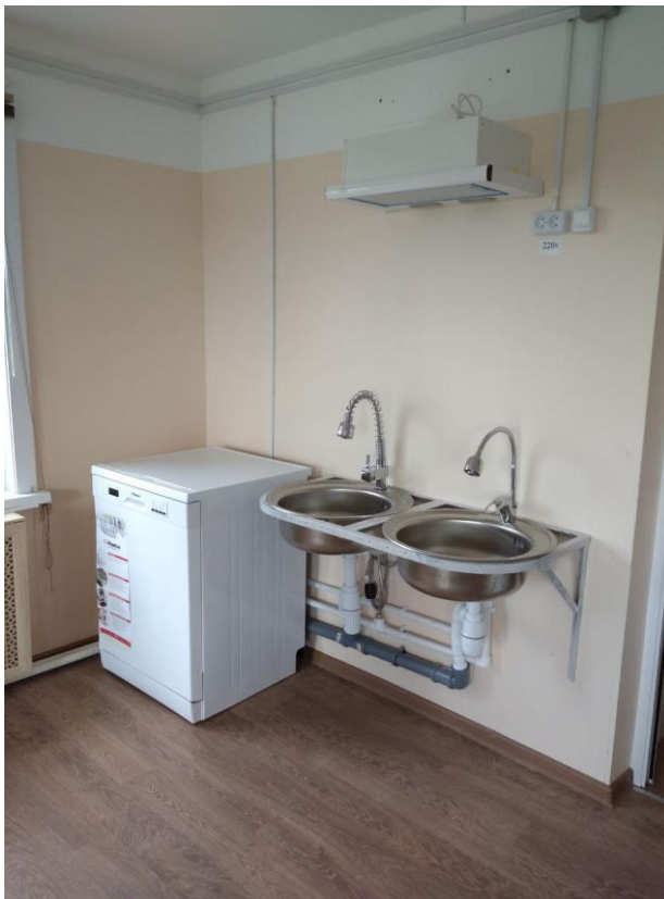
Рис.3. Групповое помещение МКДОУ ДС с. Подволошино
